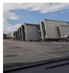
横倒しになったビル
