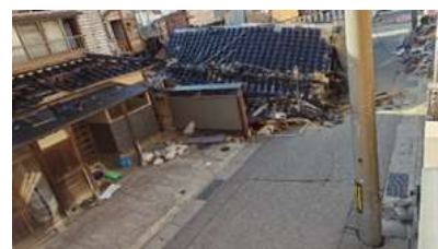
6/3 の地震の 2 日後に 倒壊した家屋
